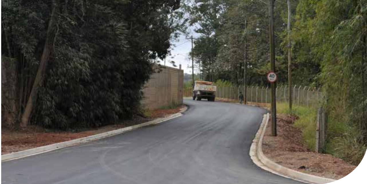
Recapeamento da Avenida Santa Rita Currupira
