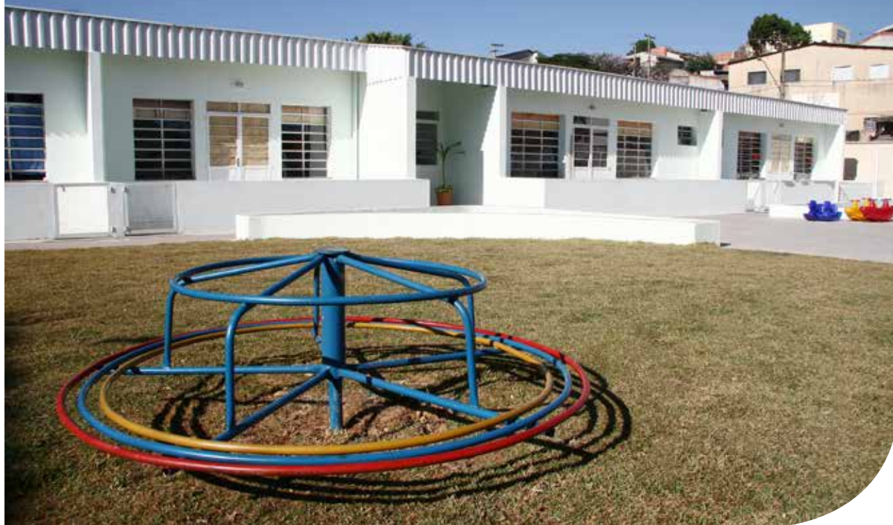
Creche no Jardim Tamoio
