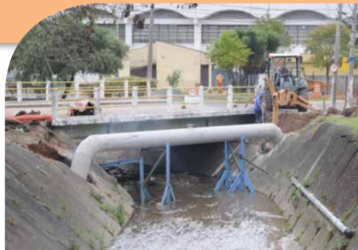
Obras de ligação da Ponte São João
