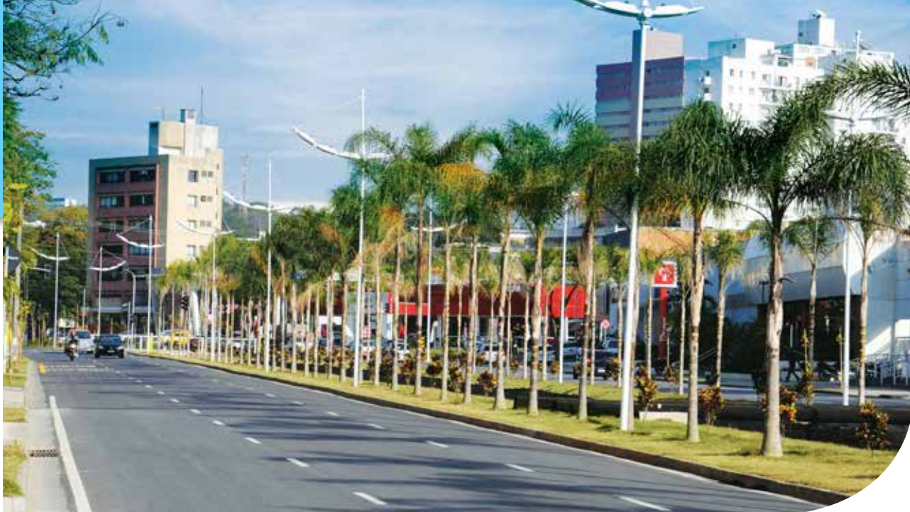
Obras na Avenida Nove de Julho iniciadas em 20XX e finalizadas em 20XX
