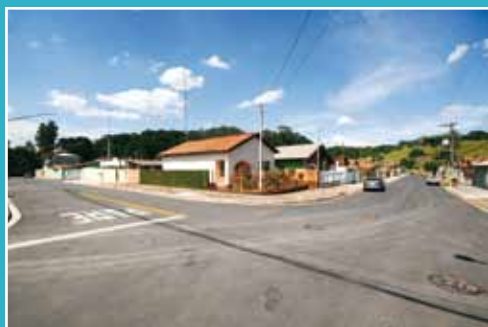
Pavimentação de ruas no Jardim Rosaura
