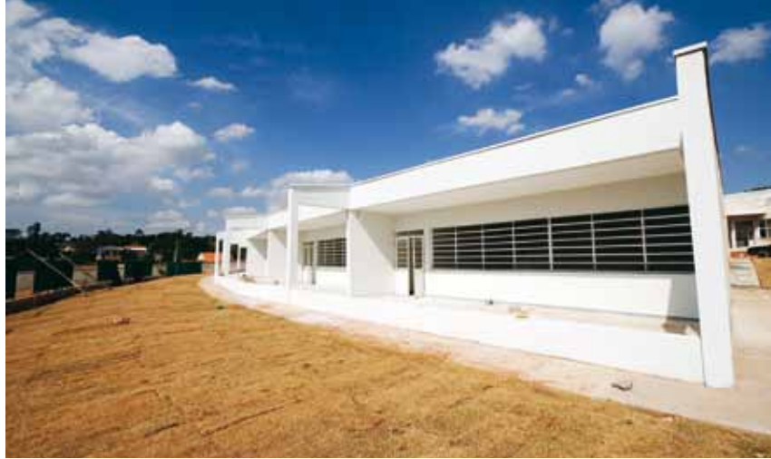
Construção da Escola Municipal de Ensino Básico na Vila Marlene
