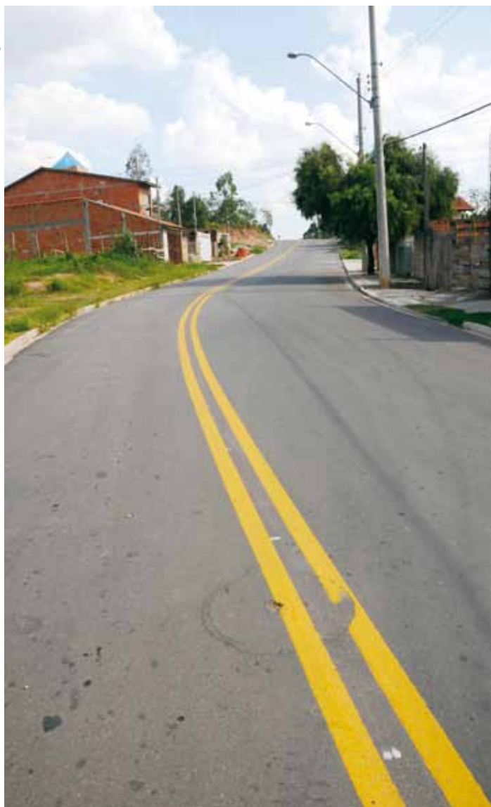
Pavimentação de ruas no Jardim Celeste
