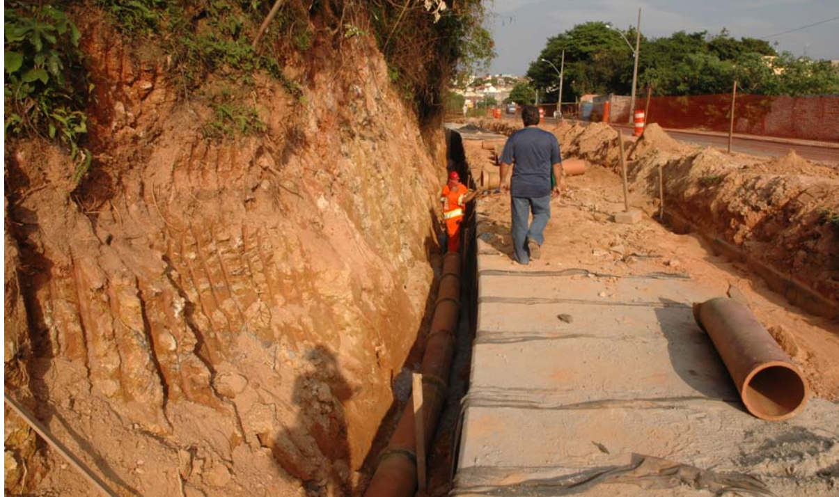
Obras no córrego Colônia
