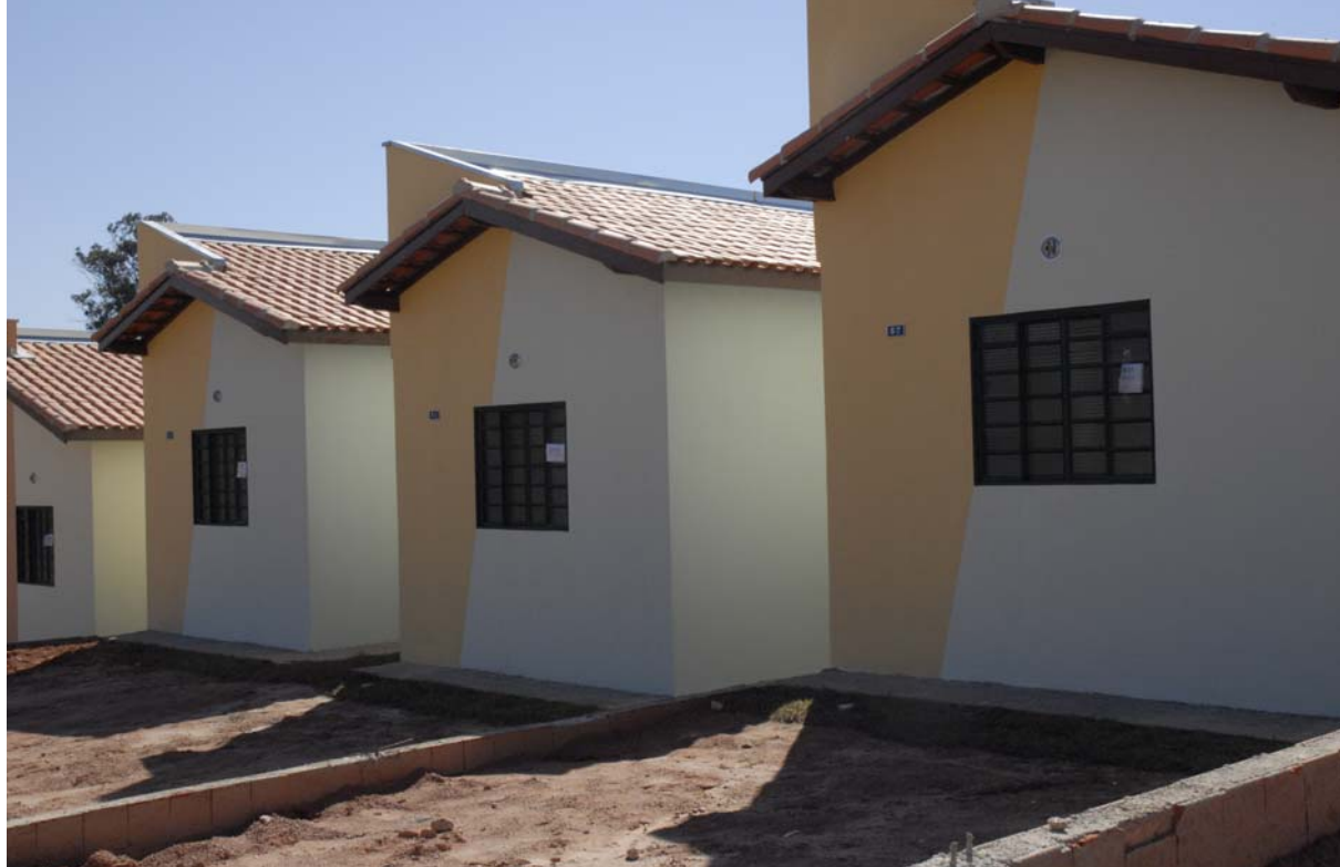
Novas casas no Conjunto Habitacional Fazenda Grande
