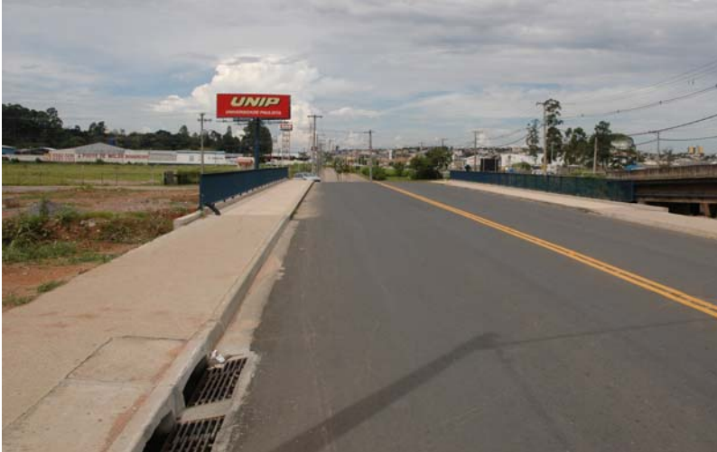
Ponte sobre o Rio Jundiáí, na marginal da Rodovia João Cereser
