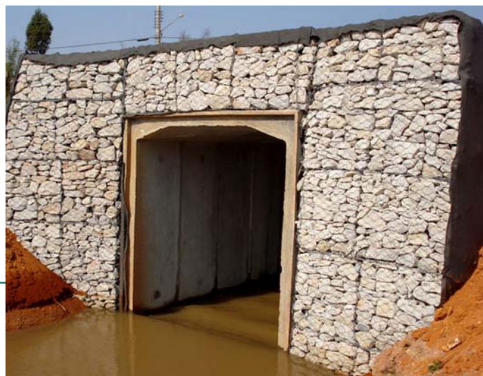
Obra de alteamento do córrego Pinheirinho
