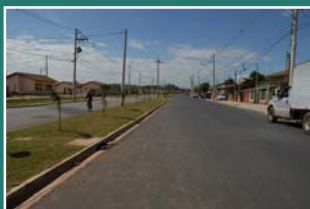
Pavimentação da estrada municipal Varjão
