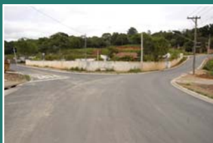
Pavimentação em Ivoturucaia
