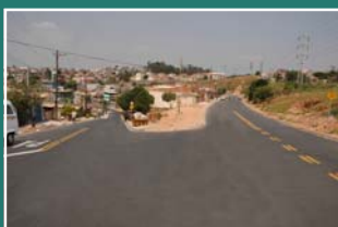
Pavimentação na Vila Nova Cidadania
