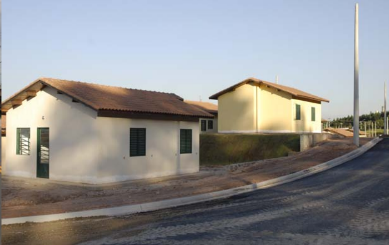
Pavimentação asfáltica e drenagem de águas pluviais do Conjunto Habitacional Jundiáí "J" - Engordadouro
