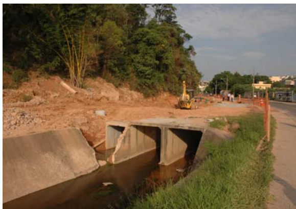
Obras no córrego Colônia
