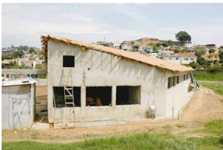
Construção da UBS Rui Barbosa
