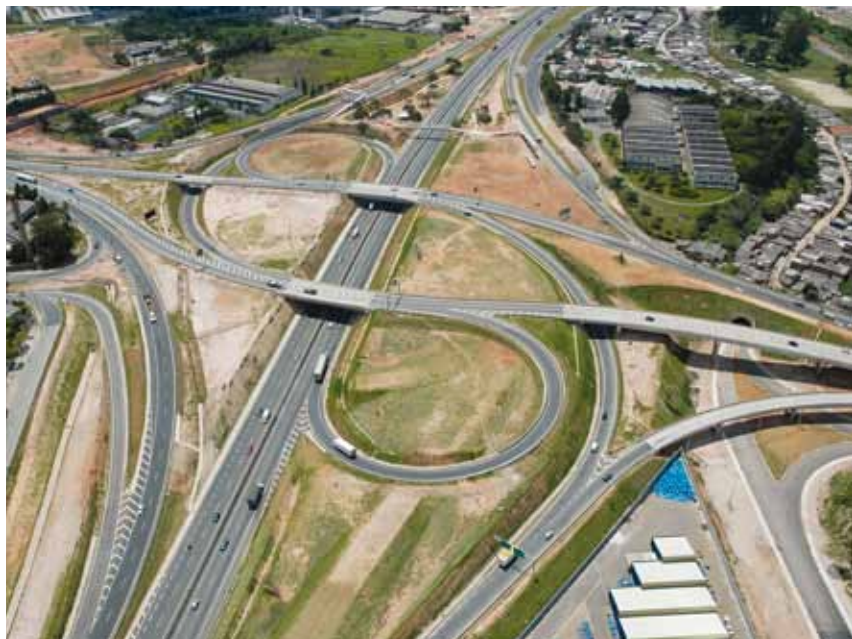
Obras de interligação urbana com o trevo do km 62 da Via Anhanguera - Trevo de Itu
