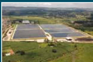
Estação de tratamento de esgoto
