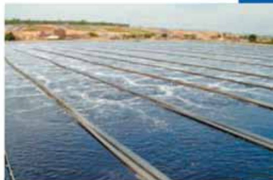
Estação de tratamento de esgoto
